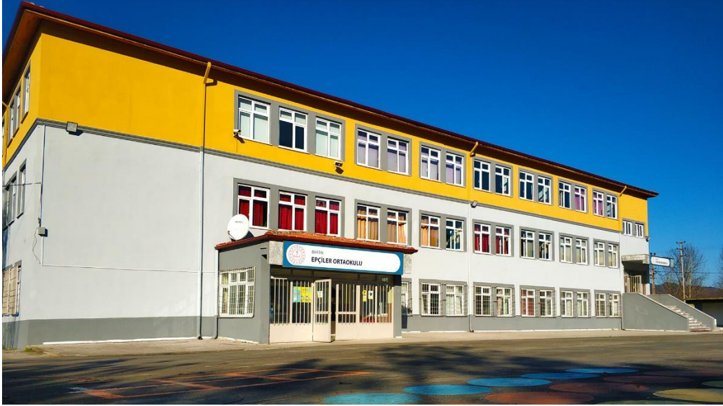
Şekil 3. Bartın Epçiler Ortaokulu Binası
